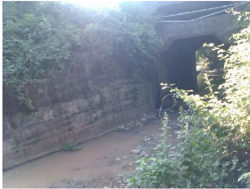
شکل (۹): تصویری از پل موجود بر روی رودخانه برزوله
