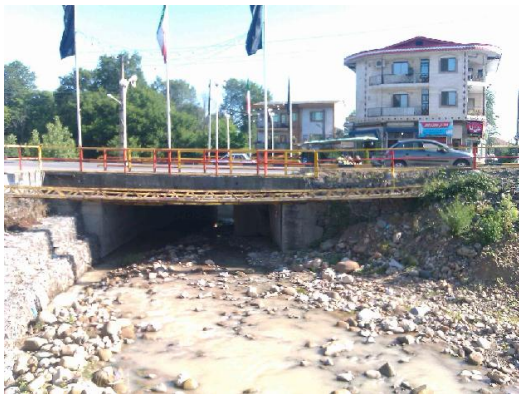
شکل (۱۰): تصویری از پل موجود بر روی رودخانه اشکلک
